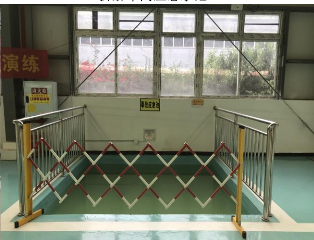
生产车间应急水池
