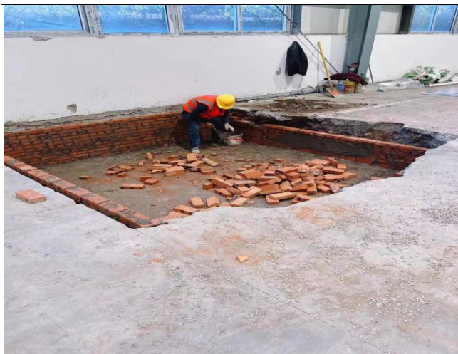
应急水池建设过程
