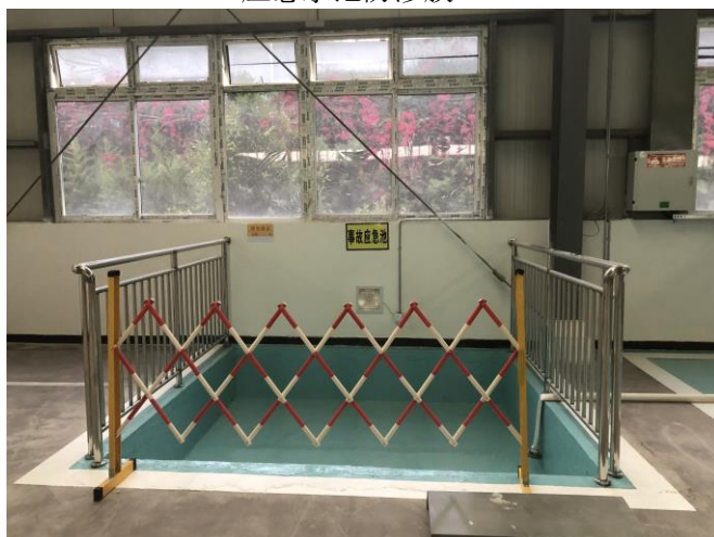
测试房应急水池
